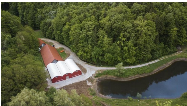
Slika 1: Recirkulacija Dvor je sestavljena iz 3 objektov, ki so funkcionalno povezani v celoto. Voda iz recirkulacije odteka v ribnik za vzrejo krapov, ki v ekosistemu ribnika pomagajo prečistiti vodo preden se vrne v vodotok (za vzrejo krapov se ne vnaša dodatna krma). Avtorica: Amadeja Knez, 2019.
