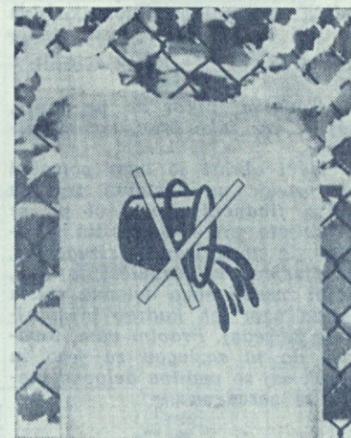
Mogoče kdo ve, kaj pomeni tale tablica na vratih ograde v transformatorsko postajo? Ali je to skrivnost...)
