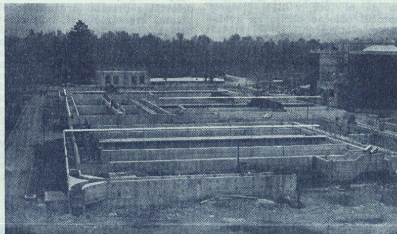
Gradnja črpalnih naprav v Domžalah
