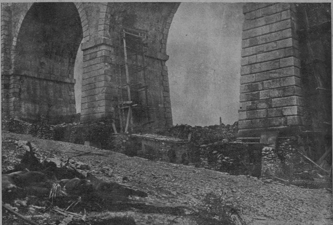
Iz Benečije: Laške postojanke ob železniškem viaduktu.
