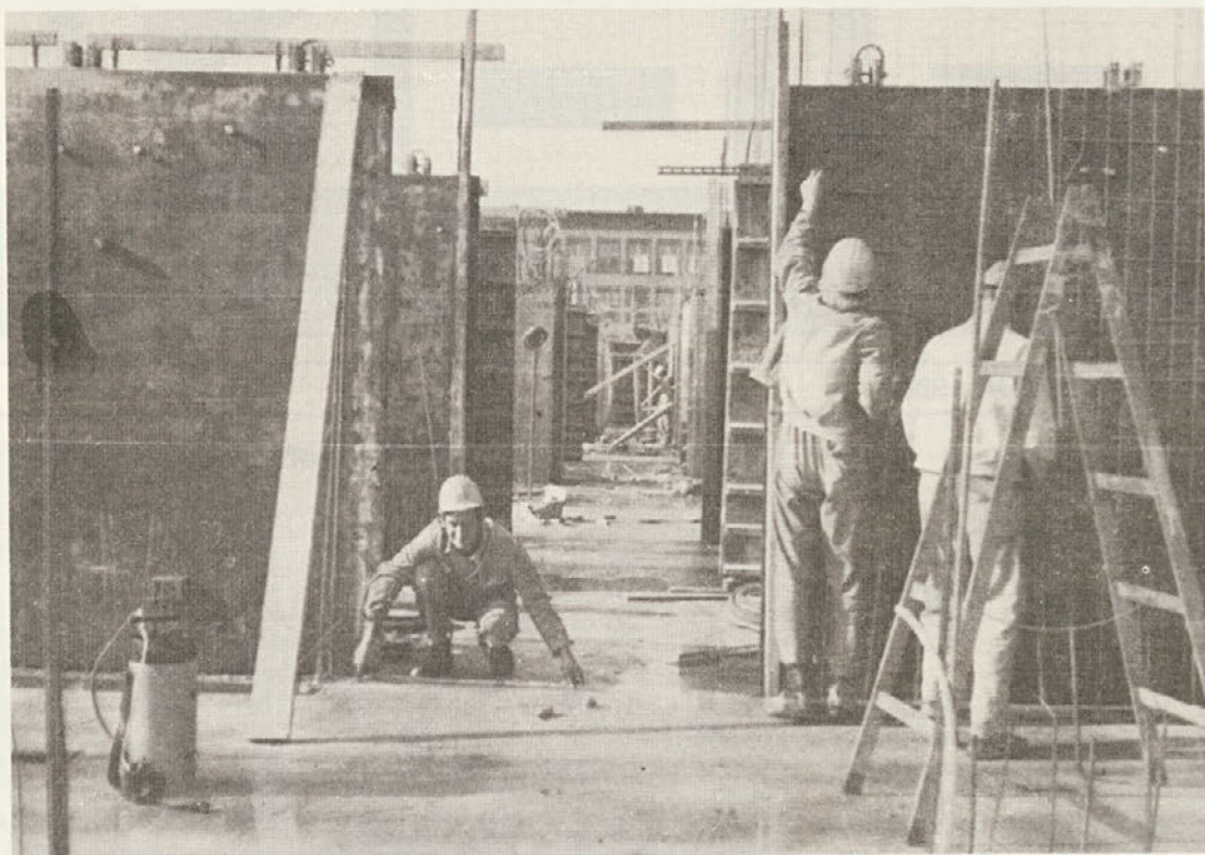
Opazenje zadnjega nadstropja hotela Solec v Varšavi z opaži vrste NOE Postavljanje oplate zadnjega kata hotela Solec v Varšavi oplatama vrste NOE
