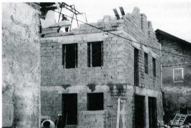
Novi prostori za gasilce.
