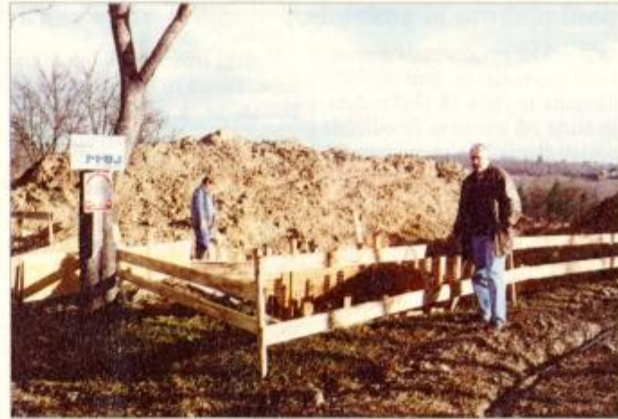
Gradbeniki so se v Sakušaku lotili gradnje enega od dveh protipožarnih rezervoarjev, ki bosta omogočala zajetje 100 tisoč litrov vode. Desno župan Alojz Kaučič.
