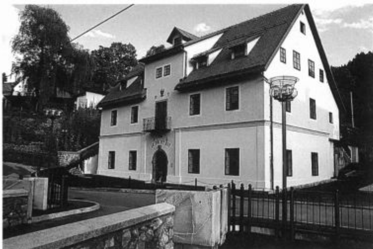
Šelštev – vhodna zgradba v Antonijev rov
