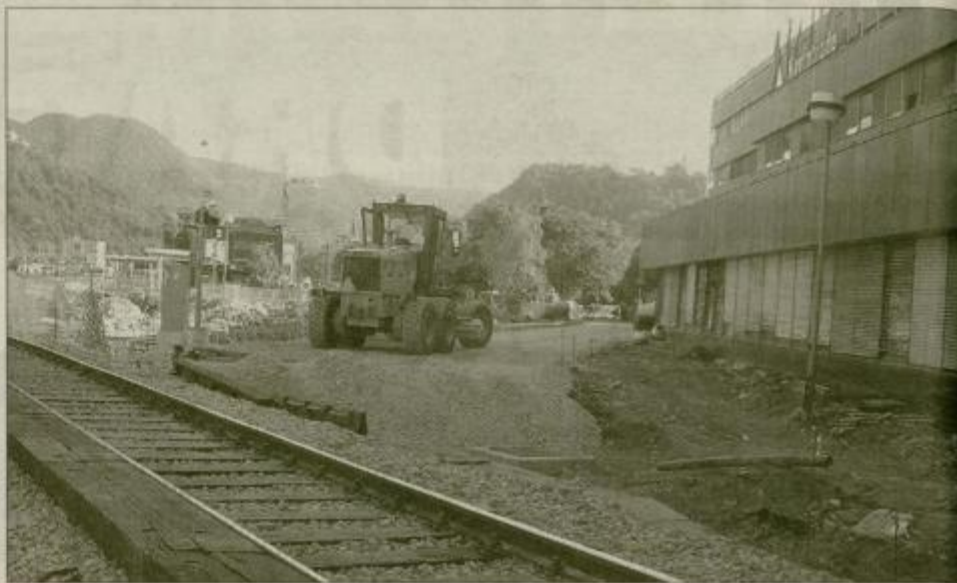
Včeraj zjutraj so delavci CM Celje zaključevali gradnjo ustroja nove obvozne ceste, ki bo omogočila dvosmerni osebni avtomobilski promet ob gradbišču.
