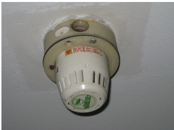
Slika 19: JAP s 74\text{ kBq }^{241}\text{Am} , ki je vgrajen na strop poslovne stavbe v centru Ljubljane (Foto: inšpekcija URSJV)
