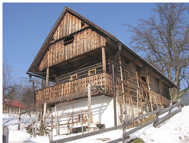
Slika 1. Mali Vrh 56, zunanost Špančeve zidanice (foto: V. Hazler, 19. 1. 2006).
