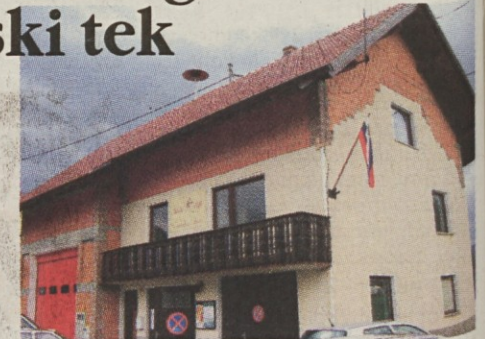
Selski gasilci so zelo dejavni tudi pri izgradnji prizidka in obnovi obstoječega gasilskega doma. Skupno so opravili preko 3000 ur prostovoljnih delovnih in strojnih ur.
