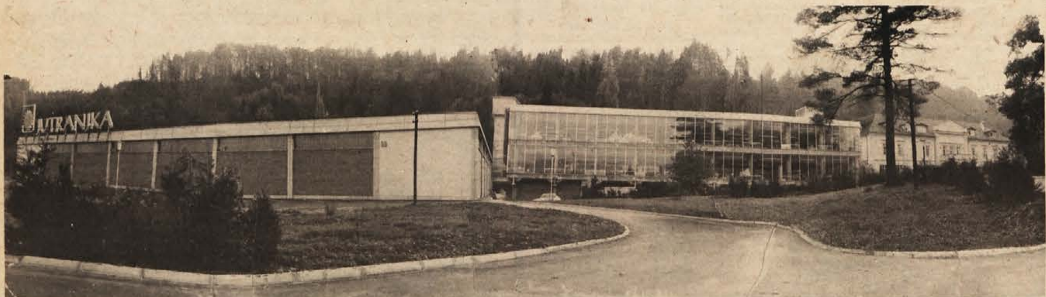
Na Radni v Sevnici je JUTRANJKA zgradila moderne proizvodne in skladiščne prostore.
