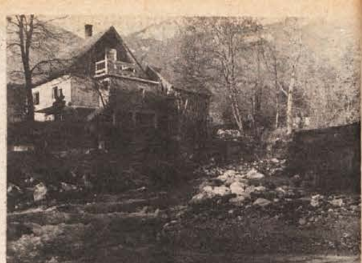
Porušeni jez ob Malnarjevi domačiji v Belici pri Osilnici v kočevski občini. (Foto: T. Ožbolt)
