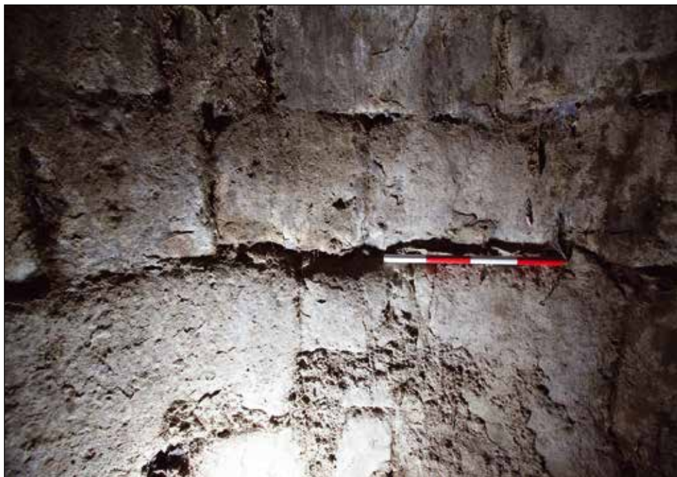
Stena trebuha, narejena iz posameznih blokov ognjevdržnega materiala (peščenjak). Ali je bil material najden v Selški dolini, bo treba še raziskati. Po robovih se vidi obraba. Foto: Andrej Bogataj
