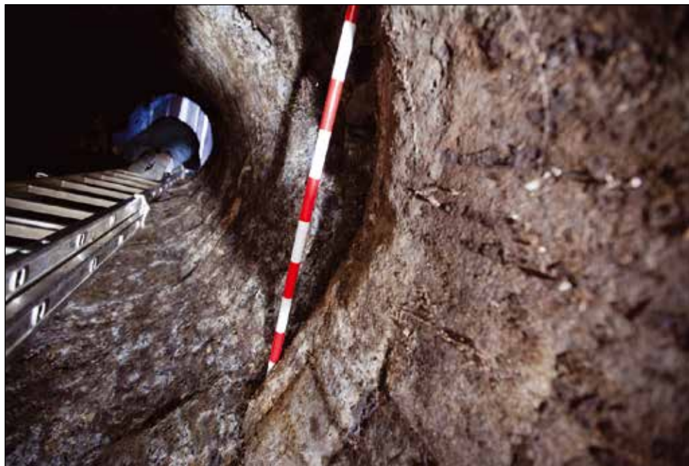
Obrabljene stene trebuha. Pri izdelavi verjetno niso bile takšne. Notranjost ni pravilen krog, ampak je ovalen. Po nekaterih virih je to lahko posledica pozicije vpihanega zraka. Potovanje vsipa (ruda, oglje, kremen) in vroči plini so naredili svoje. Foto: Andrej Bogataj
