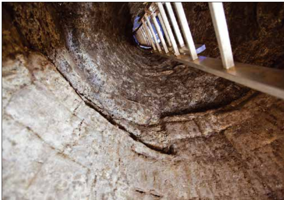
Dva različna ognjevezdržna materiala, uporabljena za izdelavo jaška. Za spust smo tokrat uporabil lestev. Foto: Andrej Bogataj
