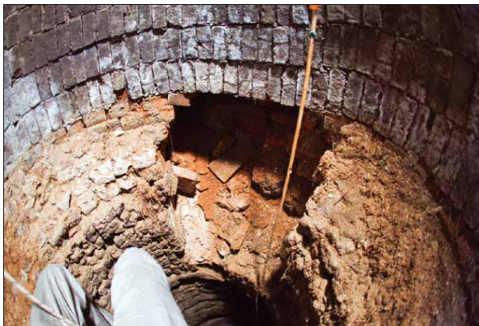
Del žrela, ki ga je načel zob časa. Oblika je prirejena za napravo za zajemanje plavžnih plinov. Foto: Andrej Bogataj
