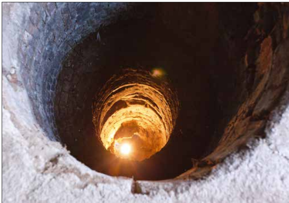
Pri drugem obisku sva notranjost plavža osvetlila od spodaj. Pogled z vsipne ploščadi (žrela) je bil kar malo zastrašujoč. Posebno potem, ko je v njem izginila tridelna lestev. Foto: Andrej Bogataj
