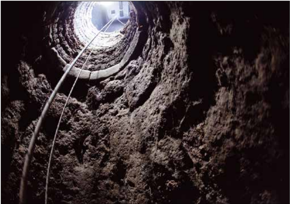
Obroč pod žrelom, ki ločuje dva različna materiala, iz katerih je zgrajen jašek. Foto: Andrej Bogataj
