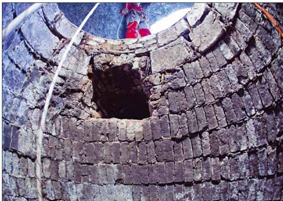
Pod vsipno ploščadjo v žrelu je vidna odprtina, skozi katero so zajemali vroče plavžne pline za ogrevanje zraka, ki so ga s pomočjo mehov vpihavali skozi šobe v spodnji del plavža in s tem povečali izkoristek samega taljenja. Foto: Andrej Bogataj
