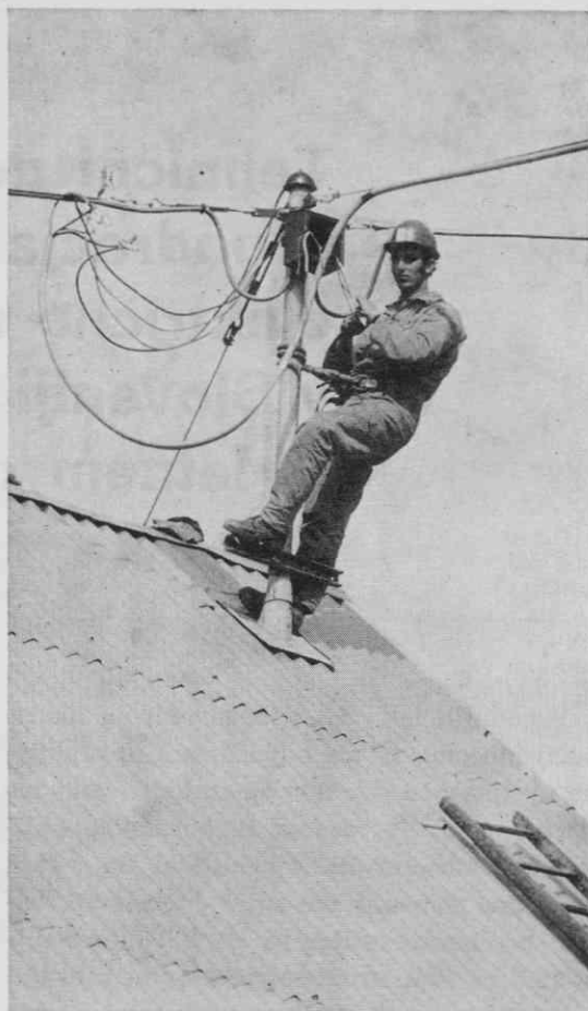
Montaža samonosnih vodnikov na strešno stojalo
