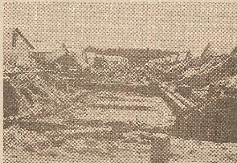
Nihče ne sluti, da je pod lepo urejeno okolico obrat Elektromontaža položil nad 20 km glavnih razvodnih kablov
