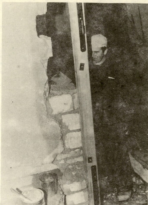
dozidavamo, prezidavamo ... zato pa dela zidarskemu mojstru ne zmanjka ...
