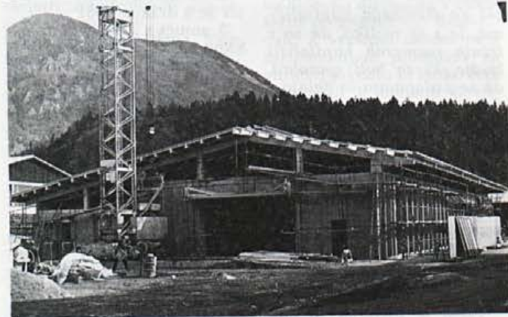
Podaljšanje in adaptacija sedanje lope za suh les — v njej bo v bodoče temperirnica lesa za program športnega orodja
