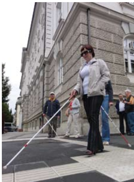
Talni taktilni vodilni sistem za slepe in slabovidne v Mariboru
