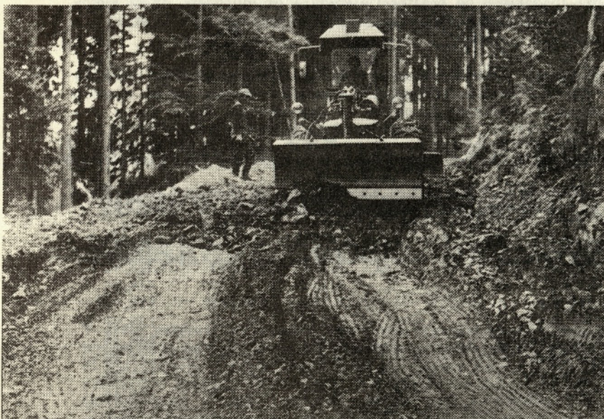
Zahtevno utrjevanje vozišča na mehkih tleh v revirju Savske jame - foto GG
