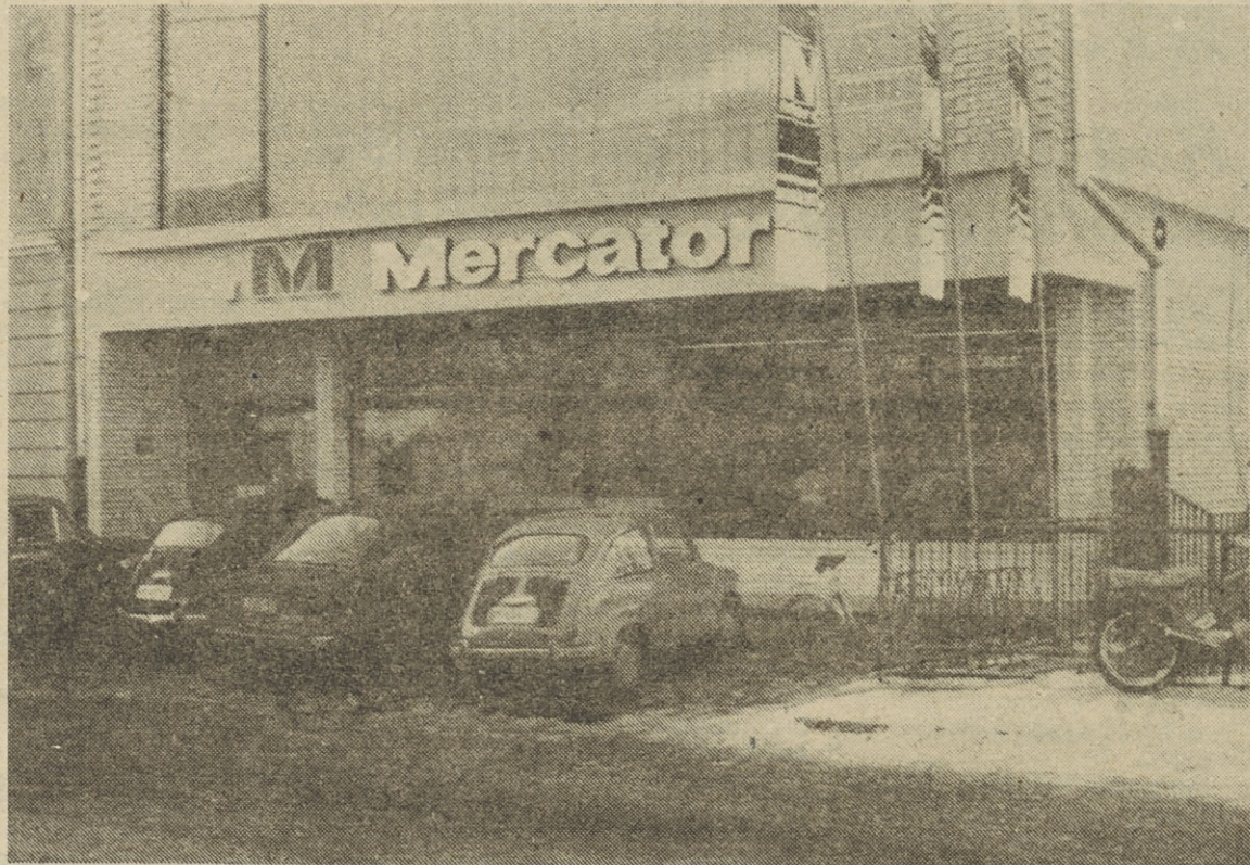
Pogled na dozidani objekt trgovine v Šentjerneju. Vse foto: Ljuba Sukovič
