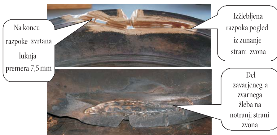
Slika 2: Prikaz zvarnega žleba za varjenje na zvonu na zunanji strani (zgoraj) in prikaz delno zavarjenega žleba z notranje strani
