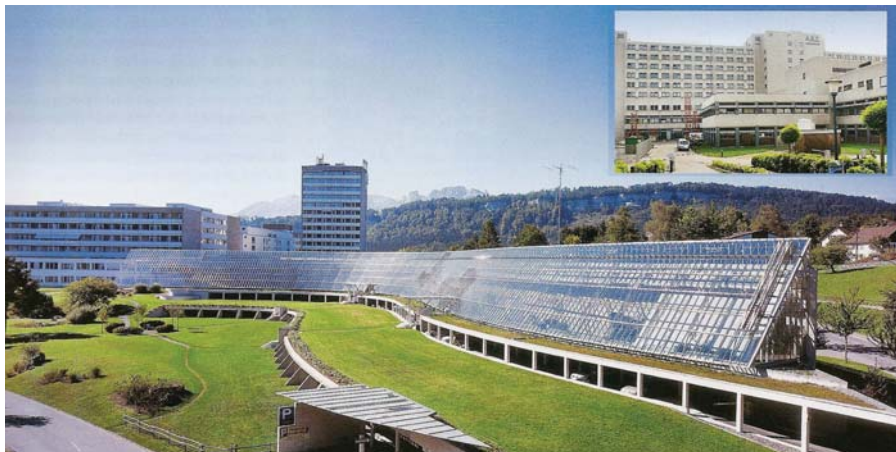
Napredne rešitve: energetska učinkovita bolnišnica Feldkirch na Dunaju in varčna belgijska klinika Aalst sta primera ekološko odgovornih stavb.
