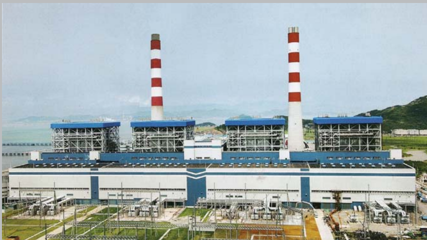
Najnaprednejša na Kitajskem: naj sodobnejša kitajska termoelektrarna na premog Yu-huan, ki ji ultrasuperkritične parne turbine zagotavljajo 45-odstotno učinkovitost
