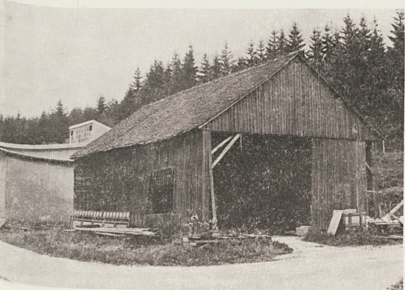
Še zadnje ostalino — zgradbo nekdanje Šerkove žage smo pred nedavnim podrli.
