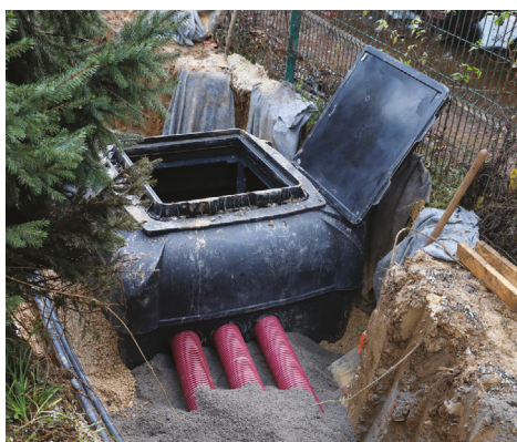
VGRADNJA – Elektro Gorenjska
