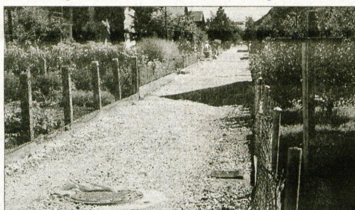
Od nekdanj asfaltirane "ulice" v vasi Trata po izgradnji kanalizacije ni ostalo nič. Novo asfaltno prevleko bodo položili šele po izgradnji plinske napeljave.
