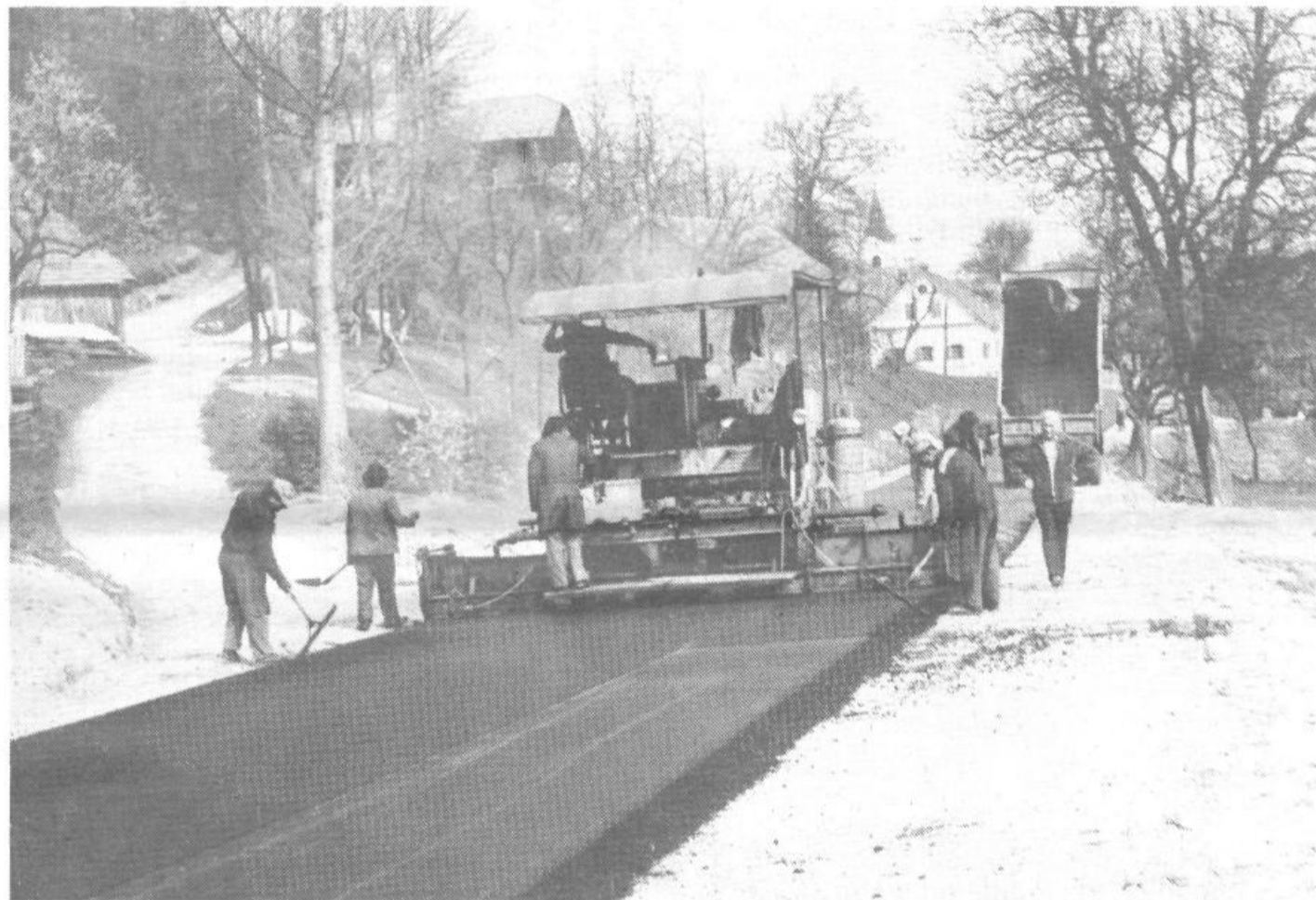
Asfalterji na delu
