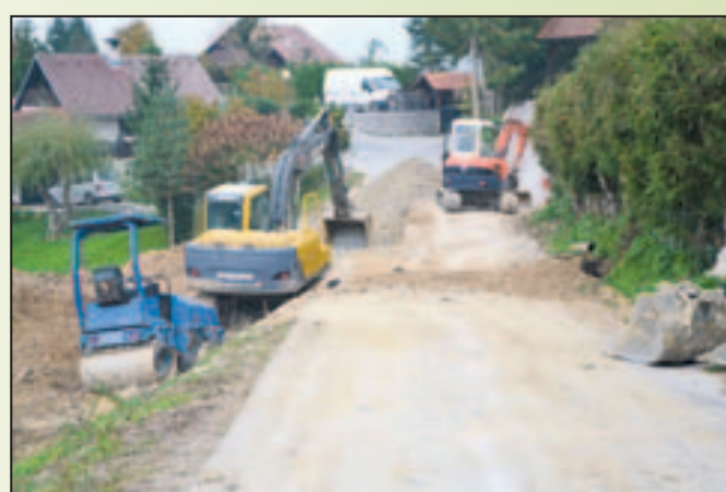
Sanacija del na javni cesti Belica-Babna Gora-Dvor
