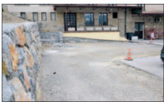
Zgornji del parkirišča, kjer je bila narejena škarpa in je podlaga pripravljena za asfaltiranje.
