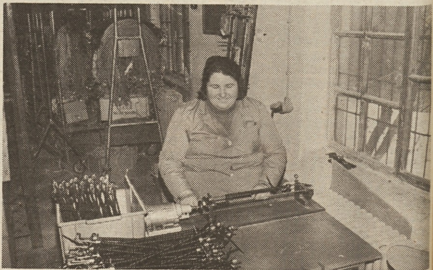
Lojzka Žitnik previja spiralne telefonske priključne vrvice.
