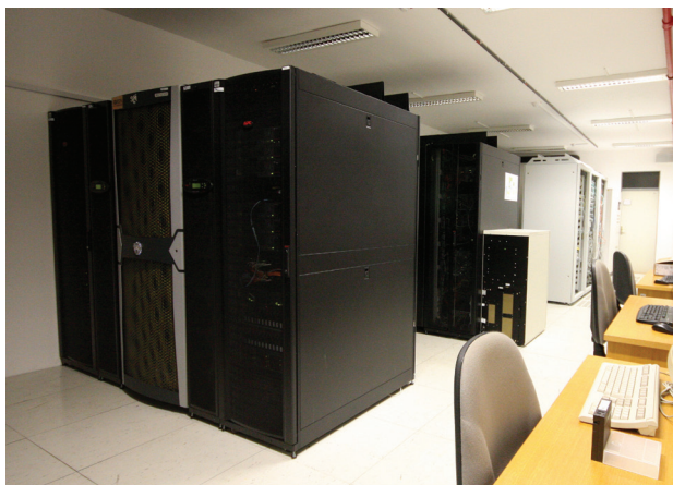
Slika 23. Računalniška infrastruktura za obvladovanje toka podatkov in njihovo shranjevanje z sistemom za neprekinjeno napajanje. (vir: ARSO)
