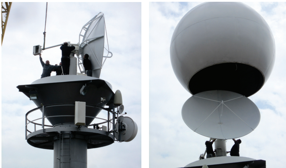
Slika 8. Zamenjava antene na obstoječem radarju na Lisci v okviru posodobitve radarske mreže. (vir: ARSO).
