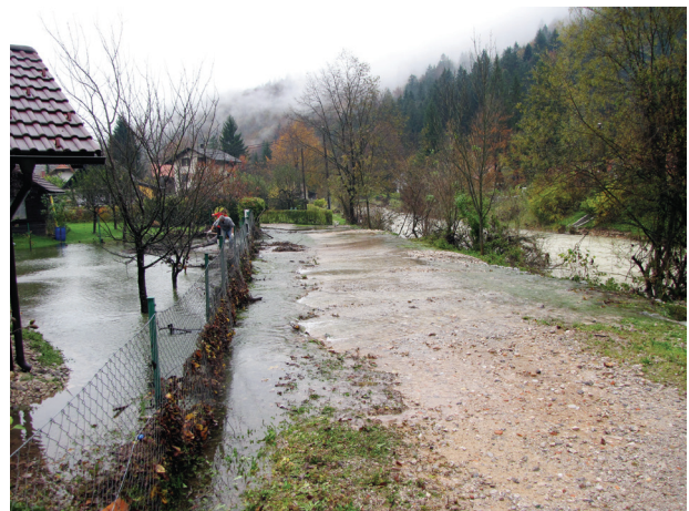
Slika 2. Odpravljanje posledic hudourniške poplave v Iški vasi dne 7. 11. 2014. Sistem je namenjen zgodnjemu odkrivanju in opozarjanju pred takimi dogodki. (vir: ARSO)
