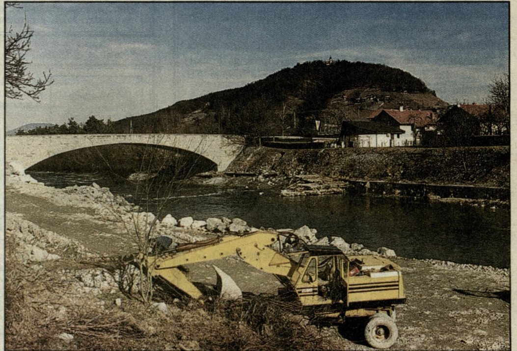
Gradnja škarpe na desnem bregu Savinje na Polzeli.
