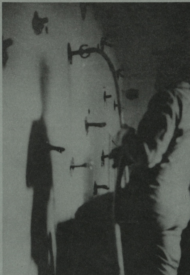
Slika 3: Injektiranje kamnitega zidu s cementno mešanico
