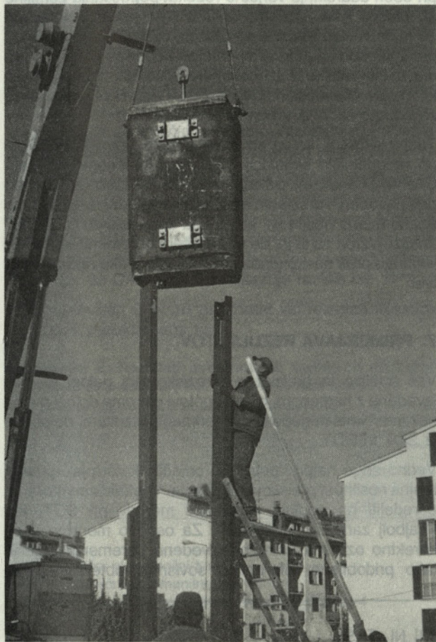
Fotografija št. 3: Dvig in nastavljanje uteži v vertikalna vodila
