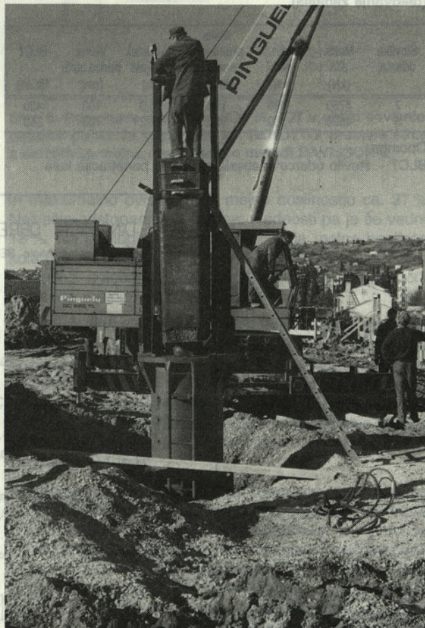
Fotografija št. 4: Zaključna montaža prostopadnega zabijala teže 120 kN za izvedbo dinamičnega obremenilnega testa
