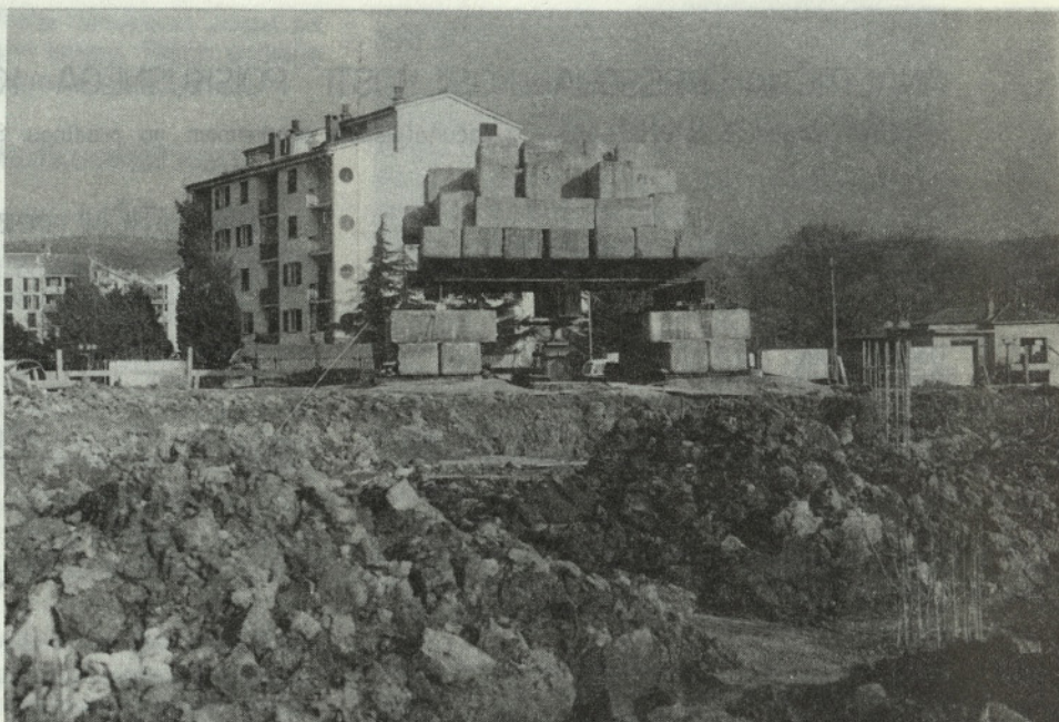
Fotografija št. 1: Konstrukcija in balast za izvedbo statičnega obremenilnega testa
