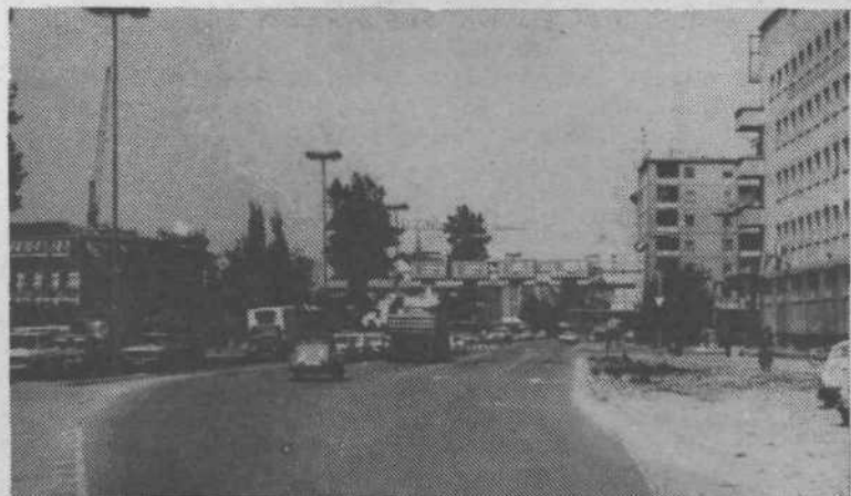
Križišče pred Delavskim domom na parni dan
