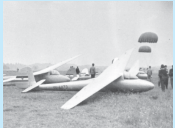
□ Slika 12. Popolnoma leseno visokosposobno jadralno letalo WEIHE (slovensko: Kanja), ki so ga nepoučeni poimenovali kar "VAJA". To letalo je bilo bržčas najuspešnejše med konstrukcijami znanega nemškega inženirja Jacobsa. Z njim so odlični piloti dosegli v 50-letih vrsto odmevnih rekordov. S Kanjo je z užitkom letel tudi avtor, vendar zaradi konstrukterskega dela premalo (arhiv Marko Malec).
