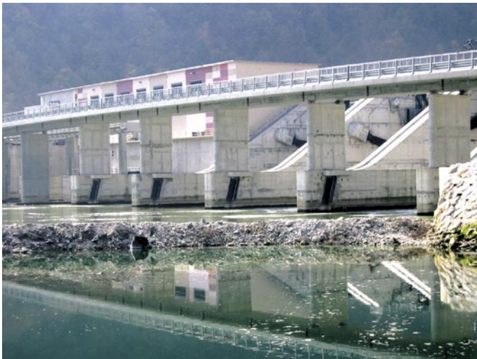
V sklopu jezovne zgradbe je na dolvodni strani zgrajen most za lokalni promet.
