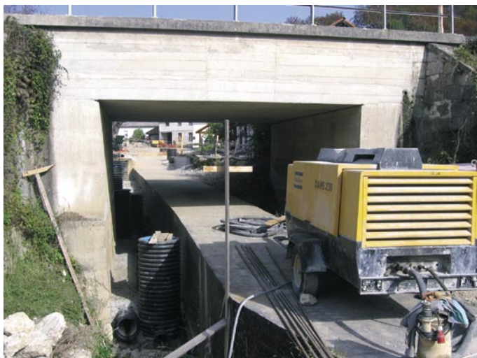
V Sevnici se je izvedla rekonstrukcija daljšega odseka izlivnega dela Florjanskega potoka ter sočasna ureditev fekalne kanalizacije. Florjanski potok, ki je bil ob poplavih Save vedno grožnja za okoliške prebivalce, je ob »božični« poplavi 2009 ostal v strugi.
