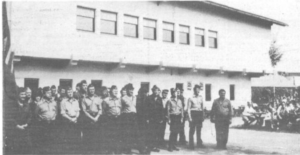
Člani gasilskega društva Brezovica so opravili pri gradnji doma 4.580 ur prostovoljnega dela.
