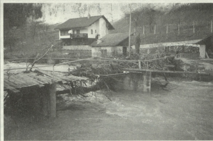
Povodenj je podrla most pri Danilu Obrezi v Penku
