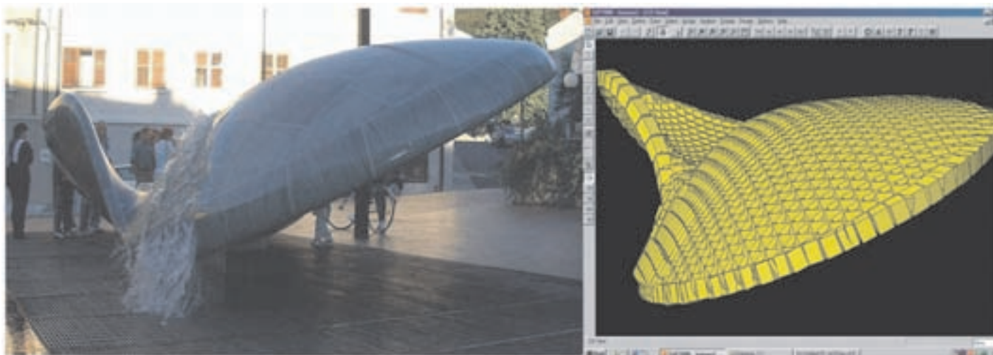
Slika 5: Lupina vodnjaka v Solkanu (3) in prikaz računskega statičnega modela s končnimi elementi (SAP000).
