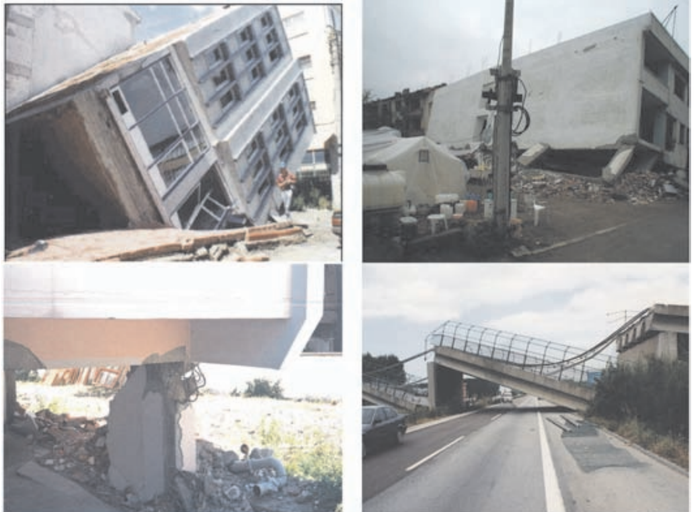
Slika 7: Potresnovarna zasnova konstrukcij. Prikaz gradnje na neustreznih temeljnih tleh, prikaz posledic izdelave mehkih etaž, prikaz poškodbe kratkih stebrov z nezadostno stremensko armaturo in prikaz zdrsa mostne konstrukcije z ležišč.
