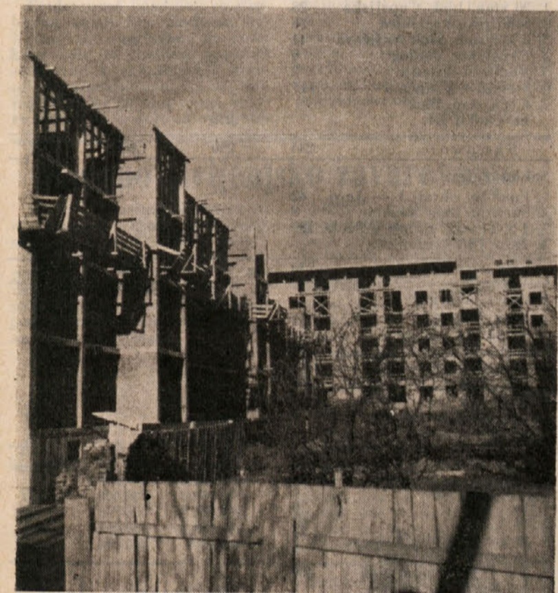
45-stanovanjski bloki B-10 in B-11, katere smo oddali investitorju že konec leta 1963 so po tlorisni — funkcionalni rešitvi in pa finančnem obračunu za investitorja zelo ugodni. Zaradi nenosilnega močvirnega terena je naše podjetje predlagalo spremembo temeljenja z masivno železobetonsko temeljno ploščo, ki je bila kasneje uporabljena tudi na drugih objektih, zgrajenih na območju Prul
