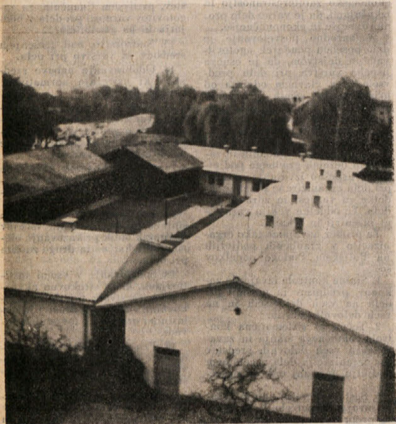
NASE NASELJE V LJUBLJANI. — Čeprav gradimo investitorjem dostikrat celo luksuzne objekte, so naši delavci kljub dobri volji upravnih in samoupravnih organov podjetja največkrat primorani, da zaradi stalnega menjanja delovnega področja še vedno stanujejo v sorazmerno skromnih stanovanjih. Ta problem bo rešen le z urejeno perspektivo in večletno načrtno gradnjo na obsežnejših lokacijah
