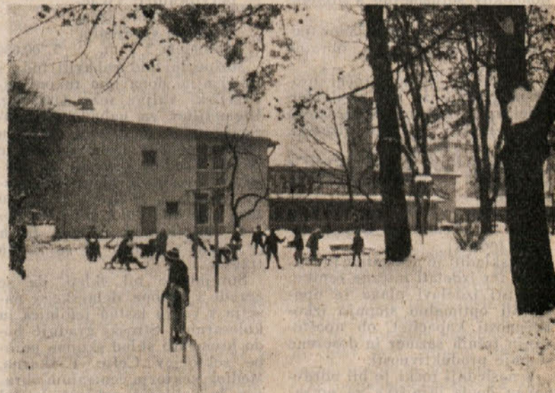
V letu 1964 smo izročili svojemu namenu med ostalimi objekti tudi otroški vrtec na Prulah. Čeprav je bilo med gradnjo vrsto tehničnih težav, ki so otežavale delo, je sedaj investitor in mi zadovoljni
