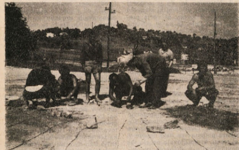
Vežanje vžigalnih kablov za vžig posameznih minskih vrst v presledkih 1/1000 sekunde na vžigalni aparat.
