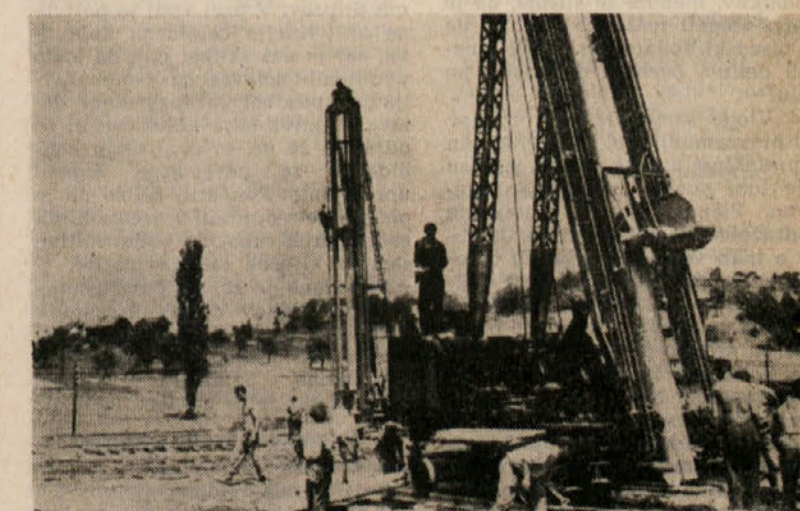
V ospredju vidimo izdelavo poševnega pilota, v ozadju zabijanje vertikalnega pilota.
