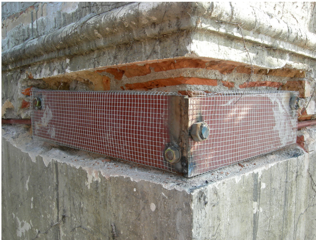
Slika 4.5: Jeklene potresne vezi
