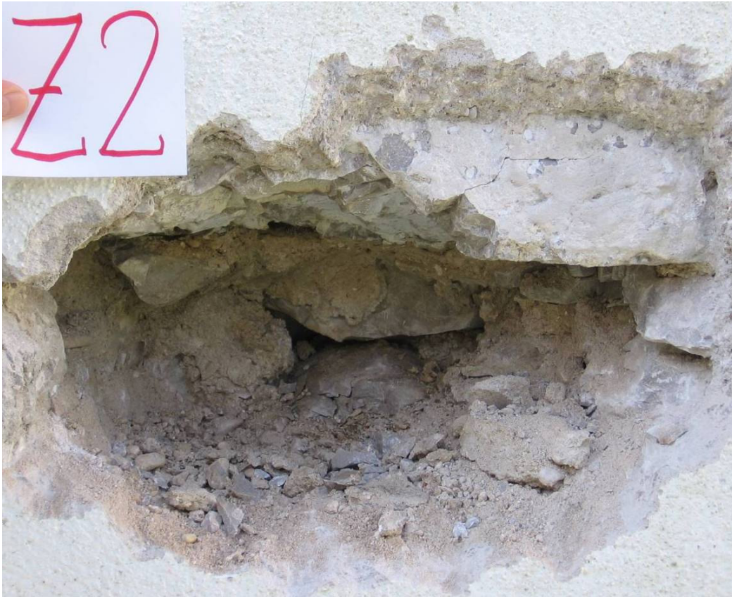
Slika 7.7: Globinska sonda kamnitega zidu, kjer se po odstranitvi večjega delno klesanega kamna iz robnega sloja zidu vidi srednji sloj iz manjših kosov kamenja in drobirja z vmesnimi prazninami
