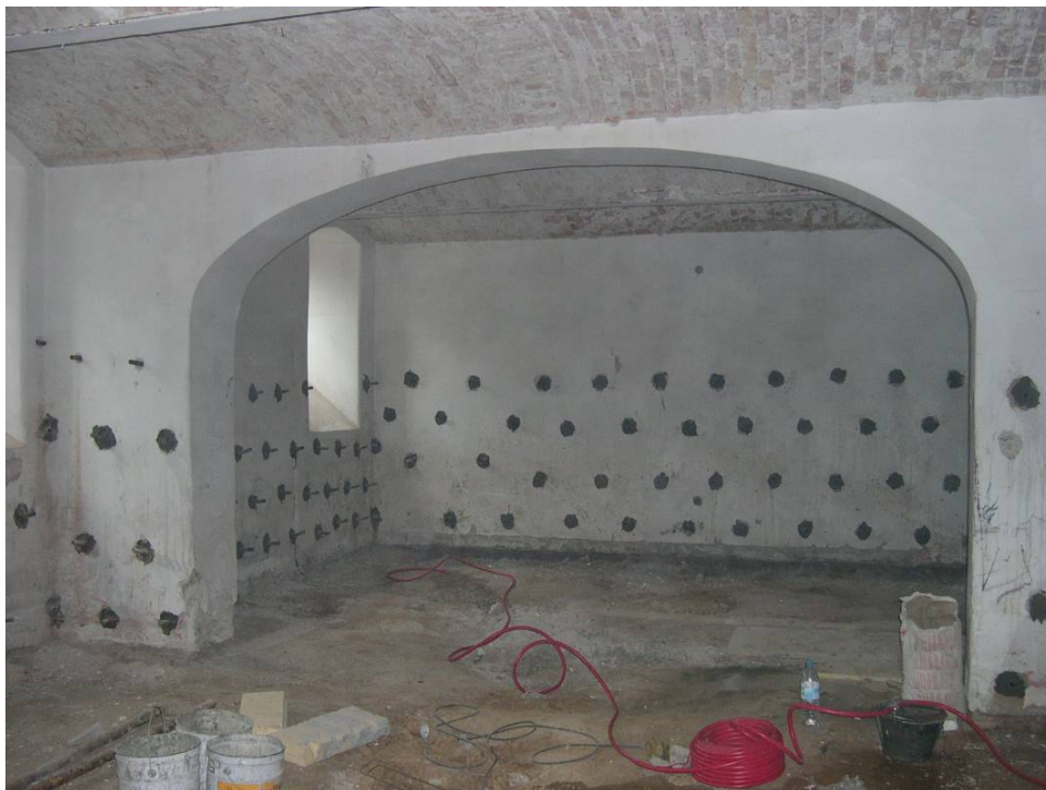
Slika 4.2: Sistematično injektiranje kamnitega zidu
