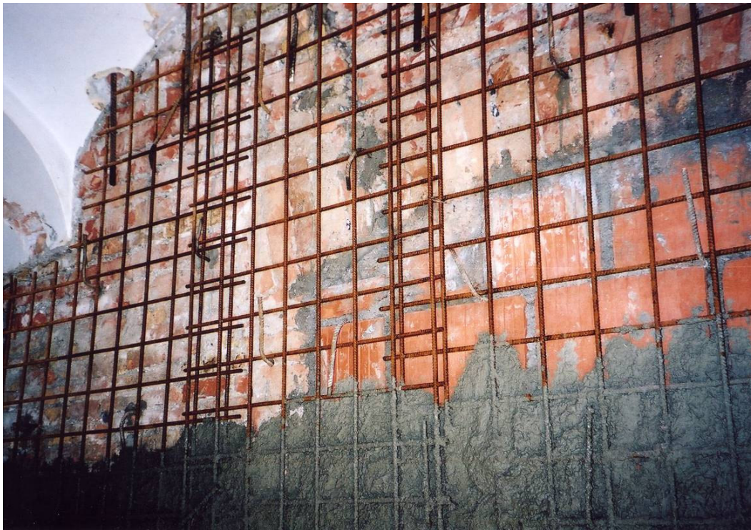
Slika 4.3: Izvedba armiranobetonskega ometa opečnega zidu
