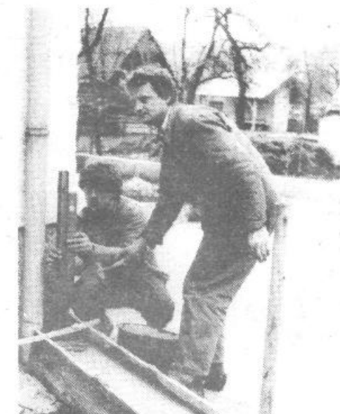
Vse toplejše spomladansko vreme je kot nalašč za zunanja dela
