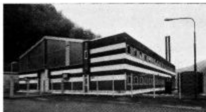
Nova proizvodna dvorana tovarne „KOLEKTOR“ Idrija.
