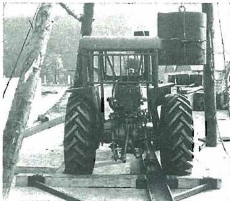
Z utežjo, ki visi na stojalu, zadajajo kabini točno odmerjene udarce. Foto Jerančič
