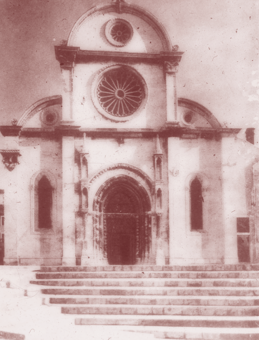
Portal z rozeto in stopniščem
