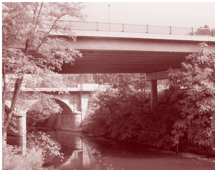
Kamnit Karlovški most čez Grubarjev prekop v Ljubljani iz 19. stoletja je mnogo lepši kot moderna betonska preklada v ospredju
