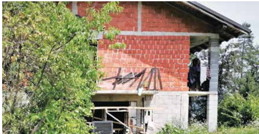
Hiša, ki se je gradila postopoma in nikoli dokončala.
