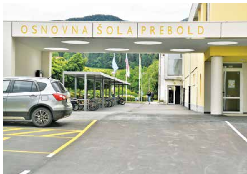
Nadstrešek in kolesarnica z novim asfaltiranim dvoriščem
