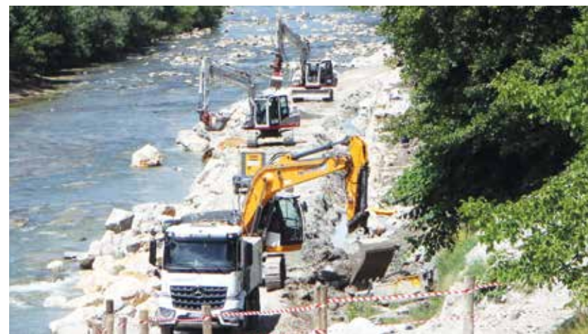
Pri sanaciji brežine Savinje
