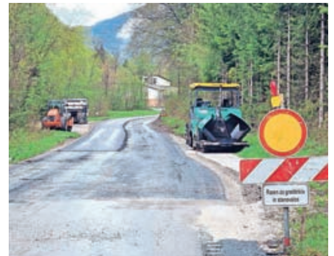
Država je daljši odsek ceste na novo preplastila tik pred prazniki. / FOTO: JASNA PALADIN
