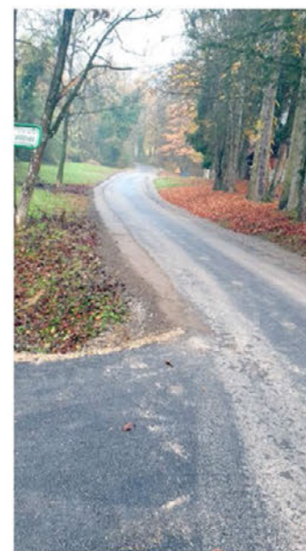
Urejena je tudi preplastitev odseka ceste Hrastovec - lovski dom
