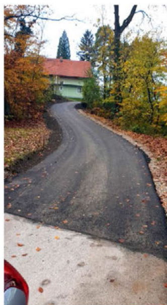
Zaključena je modernizacija ceste Hrastovec - Švabovo
