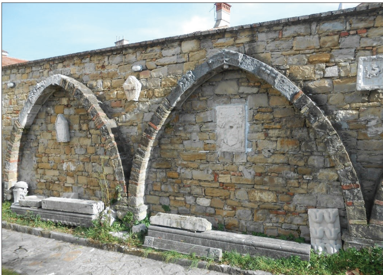
Slika 5: Obstoječe stanje fragmentov dveh izmed štirih lokov nekdanjega ciborija, vzdanih v steno muzejskega lapidarija (Foto: Jure Vuga).
