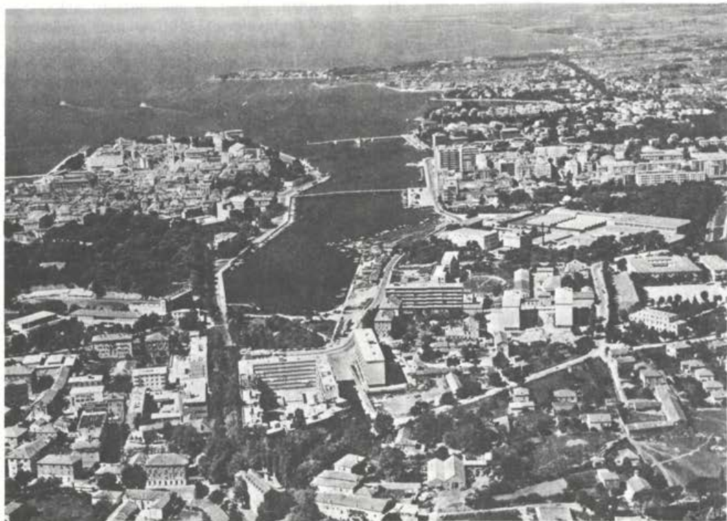
Pogled na današnji Zadar
