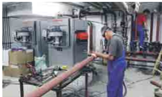
Rekonstrukcija kotlovnice na OŠ Venclja Perka
