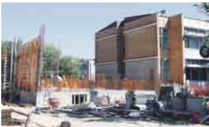
Izgradnja prizidka k OŠ Rodica
