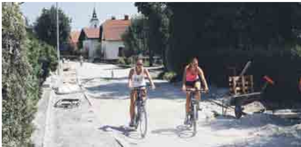
Rekonstrukcija ceste Radomeljske čete v Radomljah
