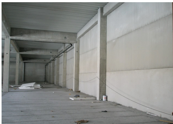
Slika 1. Analizirani tip armiranobetonskih montažnih hal.
