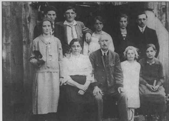
Družina Matevža Kočevarja, osebnega strežaja ("pedentarja") princa Hermana, fotografija, (last M. Kolenc, Ljubljana).
